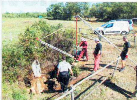
Za vađenje smeća konstruirana je specijalna dizalica
